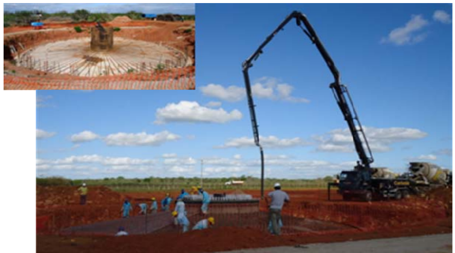
Montagem dos Anchor Cages - Fundação
